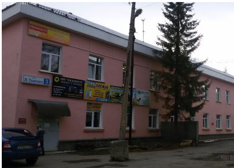
Рисунок 2 - Здание ИП «Энергия»
