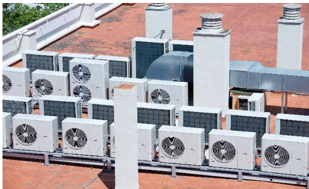
Рисунок 9 – Установка внешних блоков на крыше и задней части здания 3. Установка мульти-сплит-систем для существенного уменьшения количества чужеродных коробок на здании.
