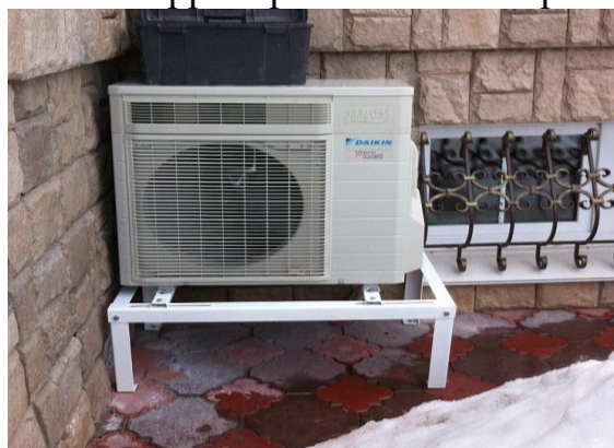
Рисунок 11 – Установка внешнего блока кондиционера
