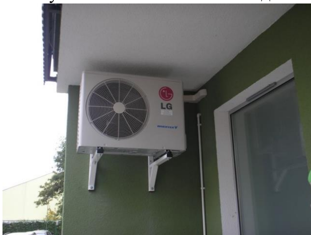
Рисунок 8 – Размещение наружного блока кондиционера на балконе
