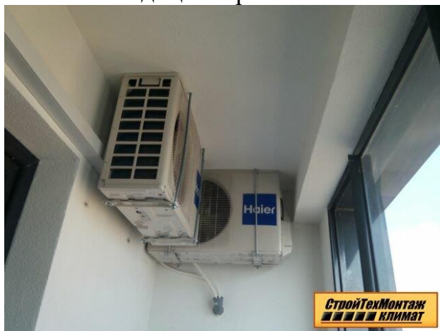
Рисунок 8 – Размещение наружного блока кондиционера на балконе
