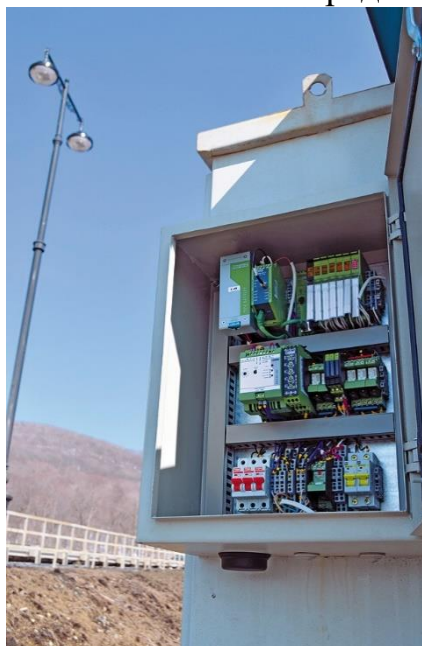
Рисунок 1 - Шкаф управления системой городского освещения во Владивостоке
